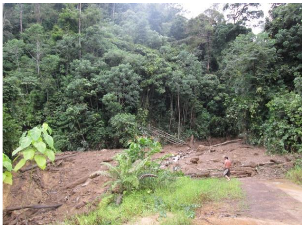
[写真 24 地滑りにより分断された道路]
